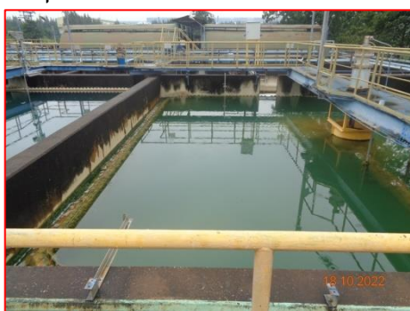
ภาพที่ 2-3 ระบบบำบัดน้ำเสีย แบบ Chemical-Physical Process
