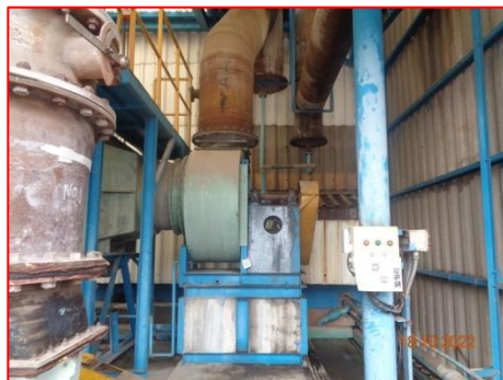
ภาพที่ 2-2 Lamellar Mist Separator
